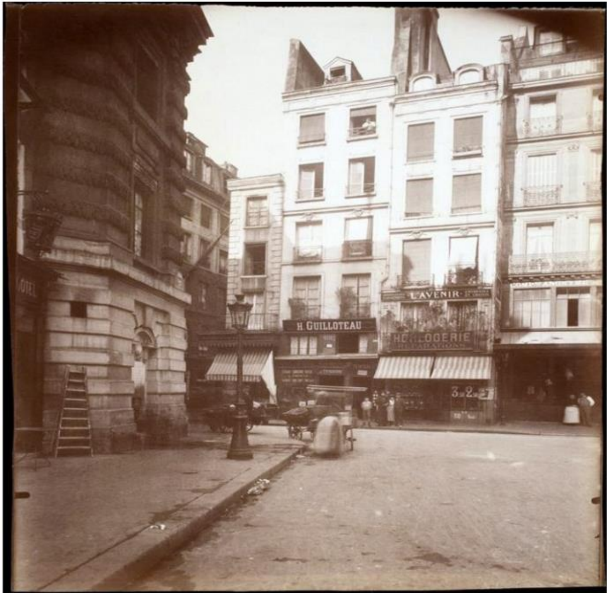
Maisons 04 et 96 rue Saint-Honoré construites sur l'emplacement où naquit Molière, photographie d'Eugène Atget en 1907.
